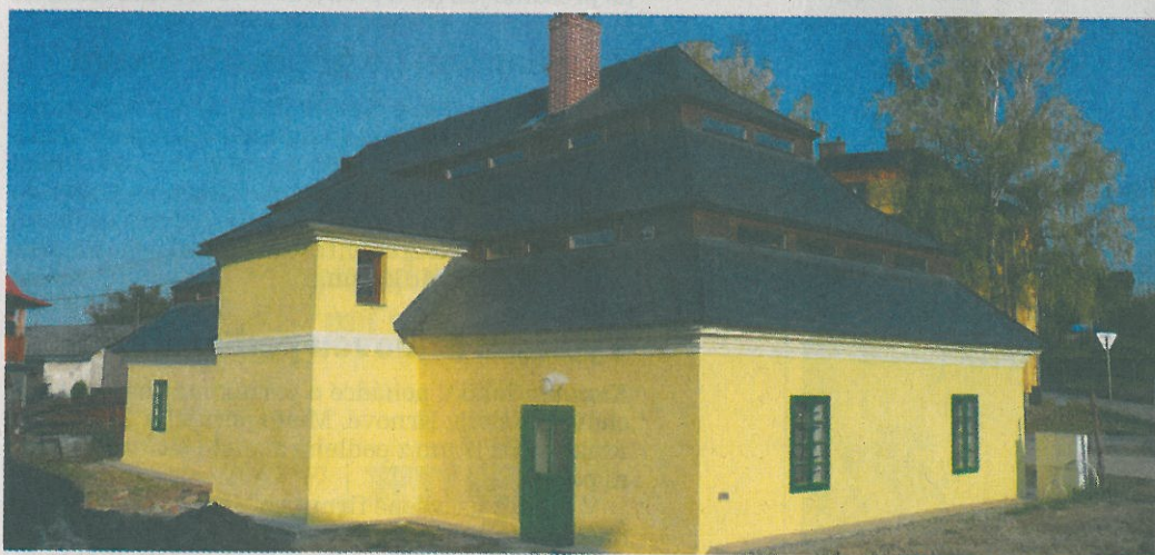
VOŠÁRNA, dříve zchátralá budova se nyní stala dominantou obce.
